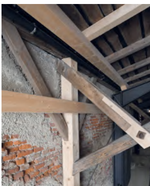
Detailarbeit: Jeder Balken wurde einzeln untersucht und aufgearbeitet, ergänzt oder ersetzt.
