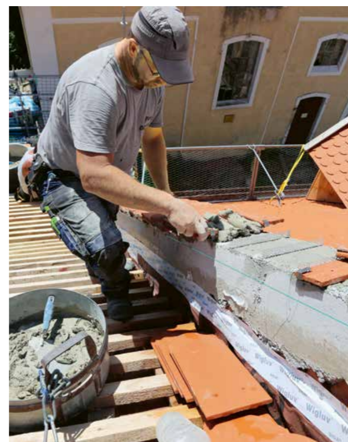
▲ Auf den Brandwänden wurden die neuen Biber im Mörtelbett verlegt
