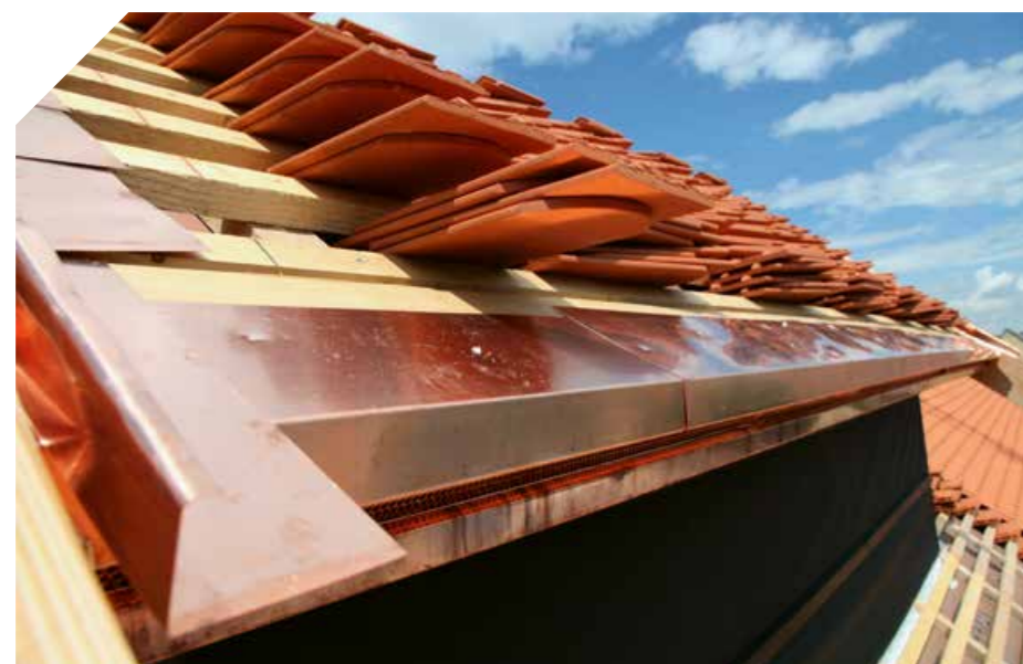
▲ Die hinterlüftete Traufausbildung an der Dachlaterne stellten die Handwerker aus Kupferblech her
