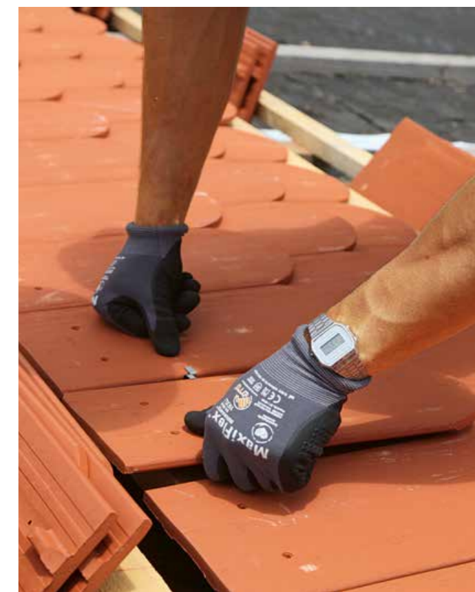
▲ Im Detail: Sturmklammern aus Edelstahl sorgen für Windsogsicherung
