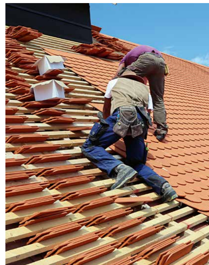
▲ Die naturroten Biberschwanzziegel wurden in Doppeldeckung verlegt
