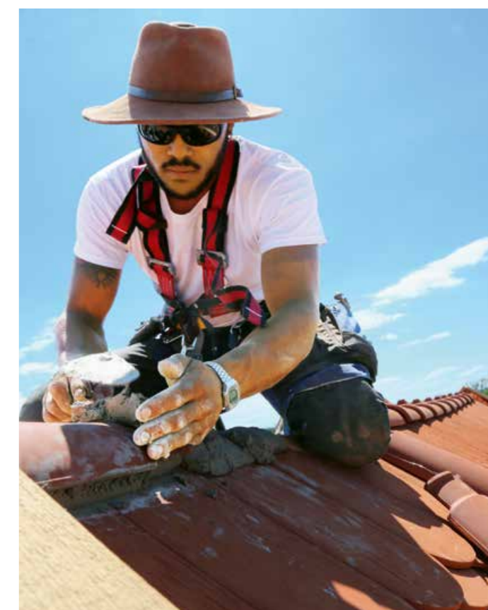
▲ Der First wurde auf Wunsch der Denkmalbehörde ebenfalls vermörtelt
